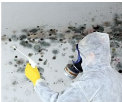
Verdacht auf Schimmelpilzallergie: Was ist zu testen? ▶ Seite 22
