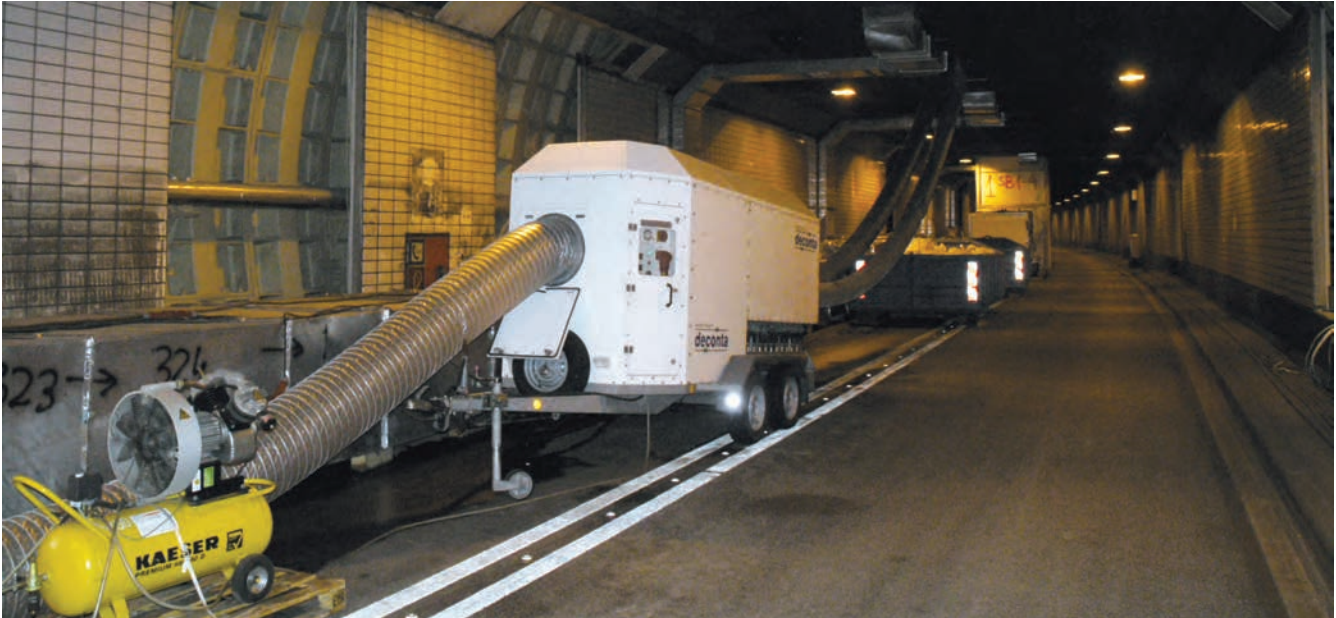
Die Mitarbeiter benötigten bei den Sanierungsarbeiten maximalen Schutz. So war die Belüftung der Teilabschnitte besonders aufwändig.
