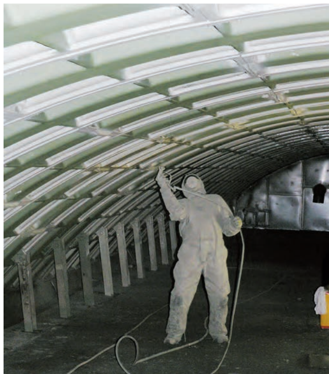
Das IPA untersuchte gemeinsam mit der BG BAU die Belastung der Beschäftigten auf aromatische Amine bei den Sanierungsarbeiten im Elbtunnel.
