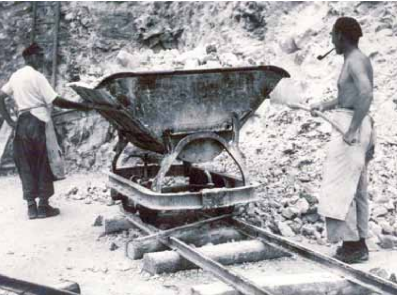
Arbeiter in der Grube Pfaffengrund um 1950.
