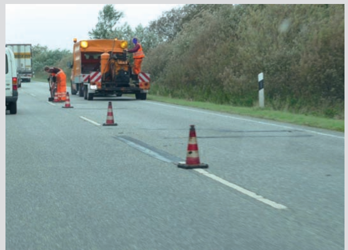
Bild 7: Bei Arbeiten direkt am Straßenverkehr beinhalten Arbeitsstellen kürzerer Dauer das höchste Unfall- und Gesundheitsrisiko
