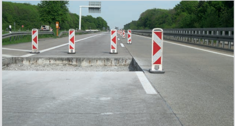
Bild 11: Keine Beschäftigten im Grenzbereich zum fließenden Verkehr: ArbStättV und ASR A5.2 müssen nicht angewendet werden
