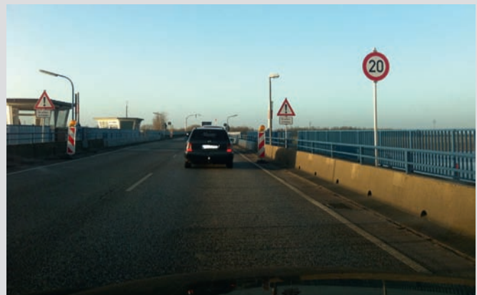
Bild 15: Beispiel für Geschwindigkeitsbegrenzung auf 20 km/h auf einer stark befahrenen Bundesstraße – Grund: Brückenschaden
