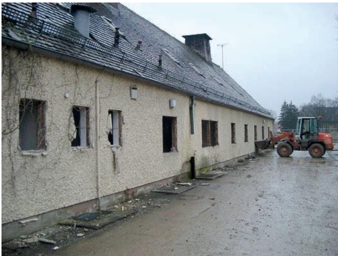
Abb. 6: Bauen im Bestand – Entkernung eines Gebäudes, in dem u.A. DDT-haltige Anstriche und Putze anzutreffen waren: Sieht man ihm das an?
