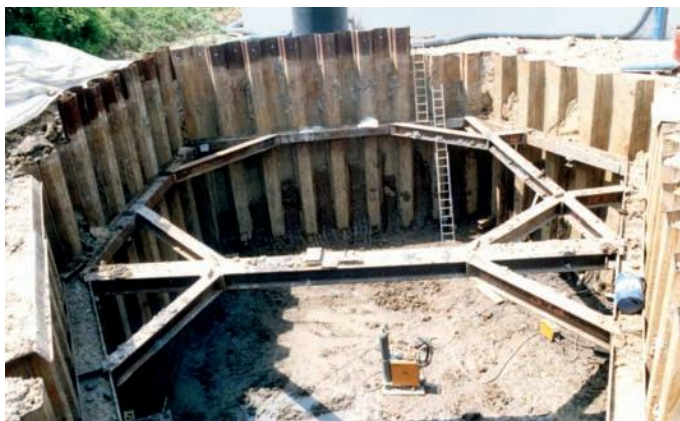
Abb. 1: Bauen im Bestand – Herstellung einer Baugrube in mit Perchllorethylen und dessen Abbauprodukten kontaminiertem Untergrund: Sieht man ihm das an?
